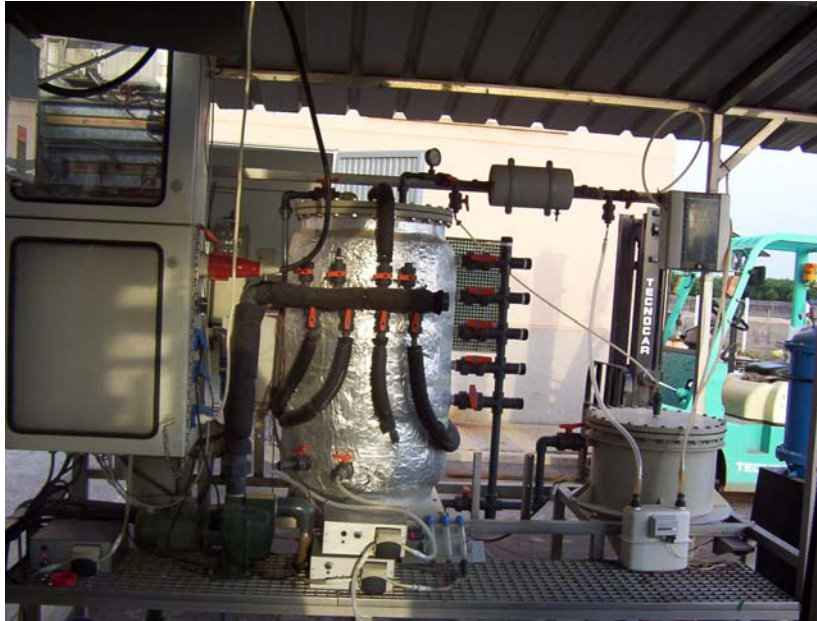
Figura 4.1. Fotografía de la planta piloto de digestión anaerobia
